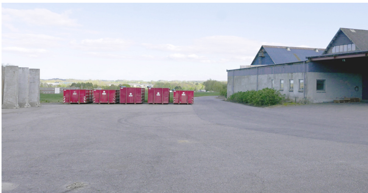
Odder Nord ligger højt, og store overflader samler store mængder vand, der skal håndteres i kloaksystemet. Der er imidlertid god plads til lokal håndtering af regnvand, hvis de grønne mellemrum udnyttes til opsamling og forsinkelse af regnvandet.
