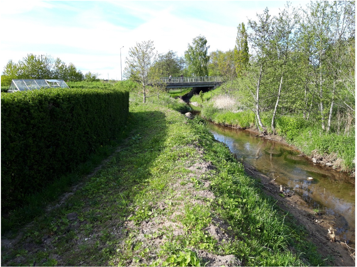
Fig. 10. Nyetableret brinkhævning i form af jorddige langs med Odde Å ved Engparken.
