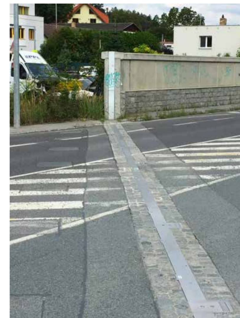
MANUEL PORT VED VEJ - 'STOP LOGS'
